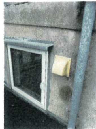
Załącznik nr 3 - Kratka wentylacyjna na naświetlu budynku
